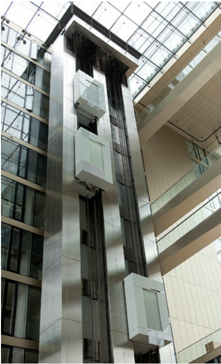
ThyssenKrupp presenterade 2003 hisssystemet TWIN med två korgar som gick oberoende av varandra i ett schakt. Här TWIN-hissar vid ThyssenKrupps huvudkontor i Essen.
